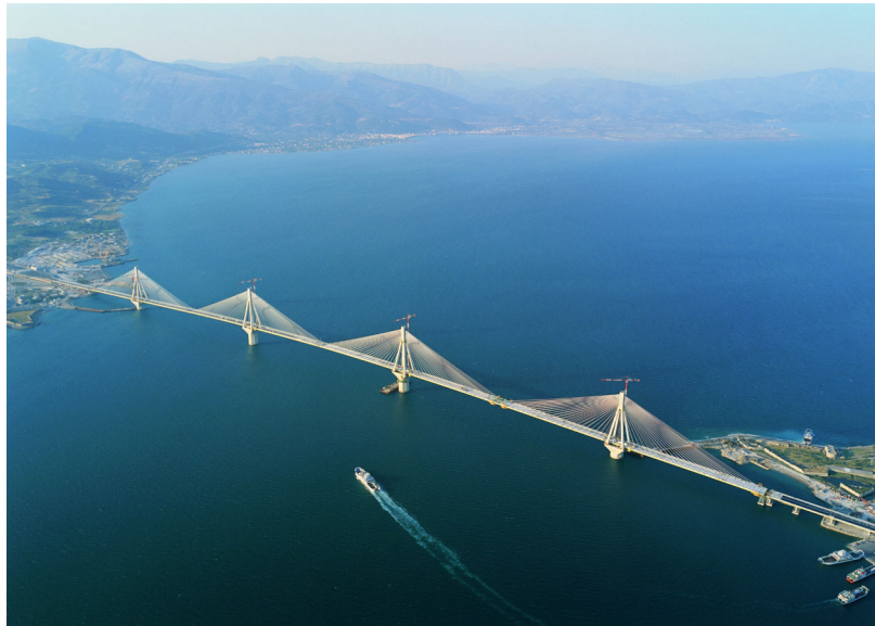
fig. 16 Vue aérienne du pont
