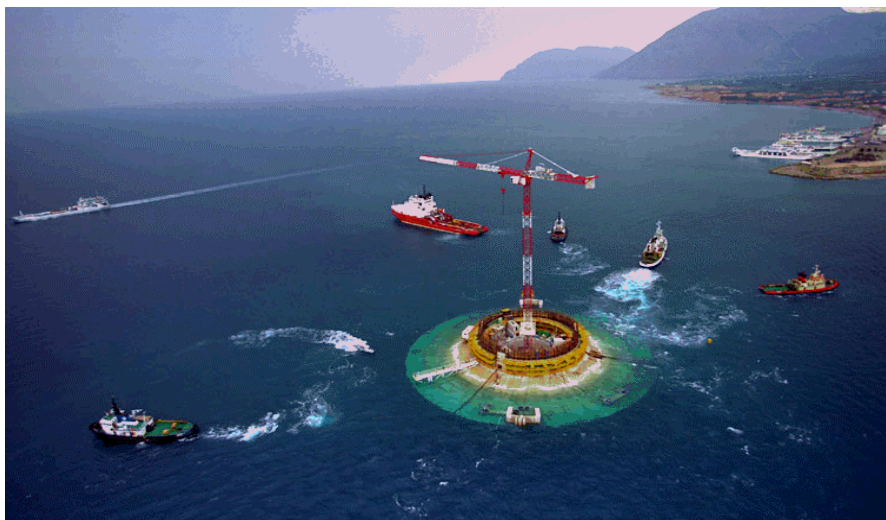
fig. 13 Remorquage d'une fondation
