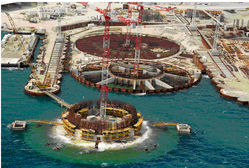
Fig. 14 Fermeture de la cale sèche par la deuxième embase
