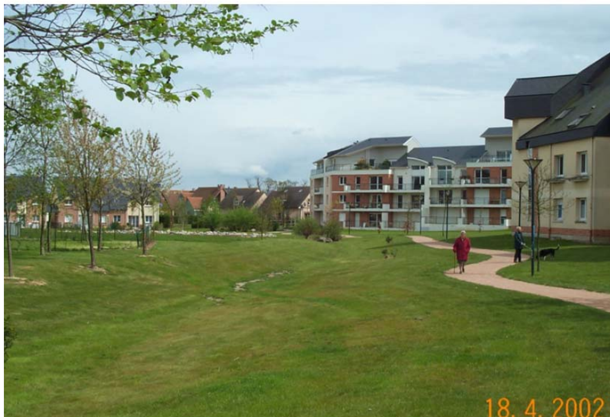
Exemple de noue en Seine-Maritime (photo F. Dégardin Certu)
