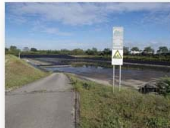
Bassin de rétention
