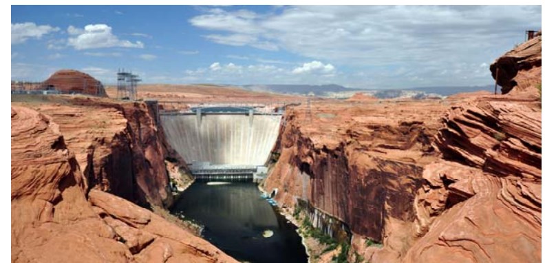
Le premier grand barrage : Hoover sur le Colorado 1935
