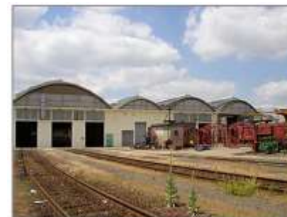
Drancy - Atelier de réparation et entretien Gare de triage Structures, charpentes et voûtes en béton. Premier quart du 20 e siècle. © CG 93, DCJS, BP, cl. A. Furio, 2003 029INV118
